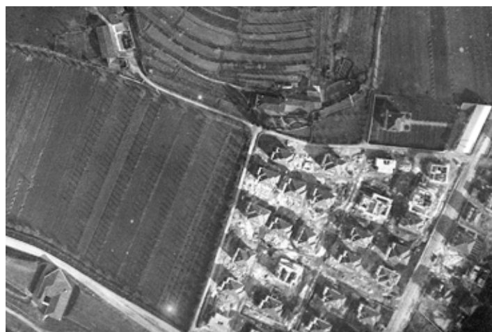
gli edifici durante la costruzione (1926)
