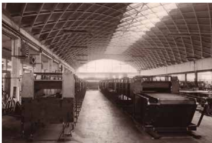
la volta a vela lamellare delle officine (1956)
