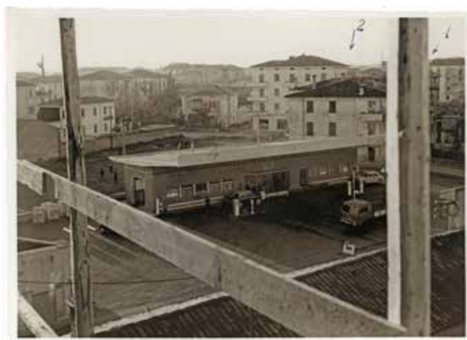
visione generale del fabbricato (1961)
