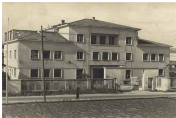
il fabbricato uffici nel 1969
