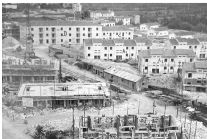
visione generale del cantiere (1950)
